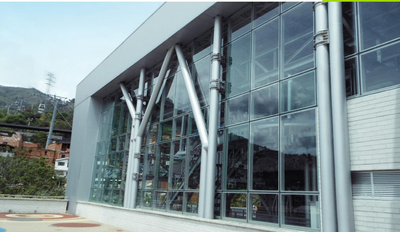
Sistema tradicional de montantes (verticales) y travesaños (horizontales), en la que sus componentes se ensamblan pieza por pieza en la estructura del edificio.
